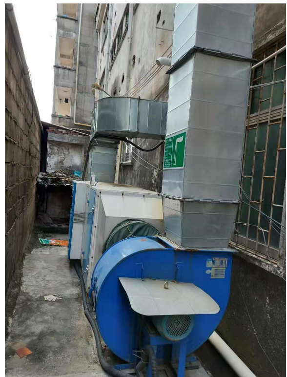
废气排放口标志牌远景
