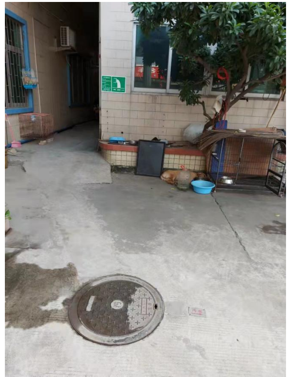
污水排放口标志牌远景
